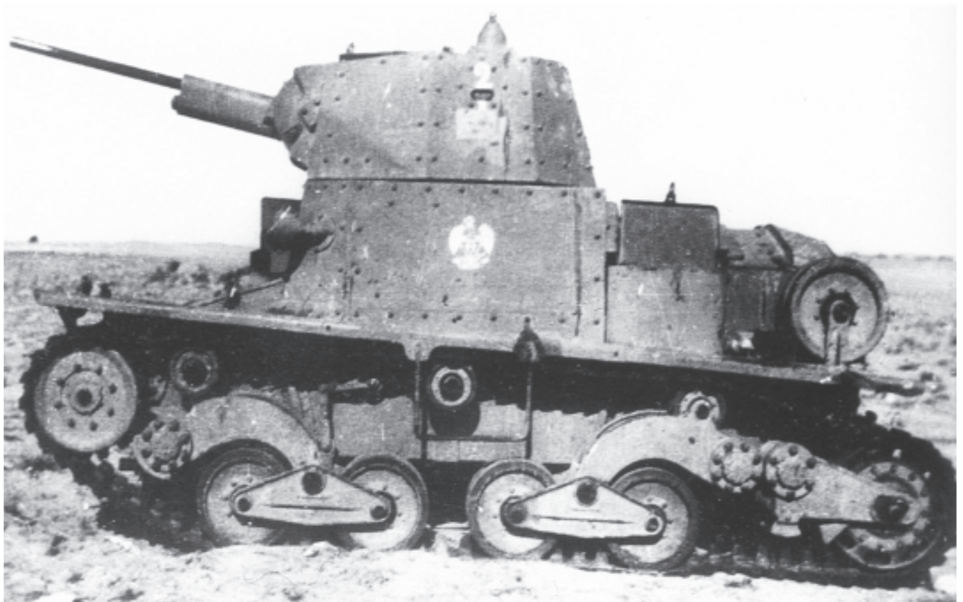
Ancora uno dei carri di Novara abbandonato nel deserto. La mancanza di rimorchi muniti di verricello per il recupero dei carri, ha aumentato notevolmente il numero di messi persi a causa dell'impossibilità di recuperarli una volta vittime di avarie o danni leggeri derivanti dal combattimento (foto AUSSME)
