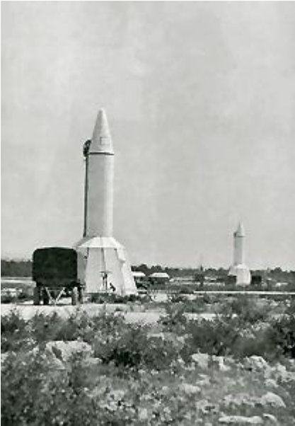
Immagine 1: Due Jupiter sulle rampe di una delle sette basi dell'Alta Murgia
